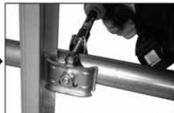
インパクト (ラチェット) で締めるだけ。
