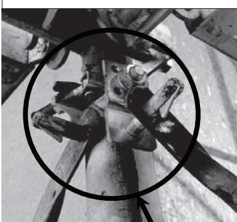
布板受材専用筋違止クランプ（上部）
