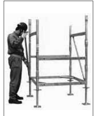
④ ダイアゴナルストラットを取付けます。タワー上端部分になるまで③④の作業を繰り返します。高所では枠足場、高所作業台、高所作業車等を利用します。
