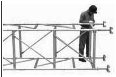
⑤ ヘッドスピンドルを差し込み、セーフティストラップで固定します。
