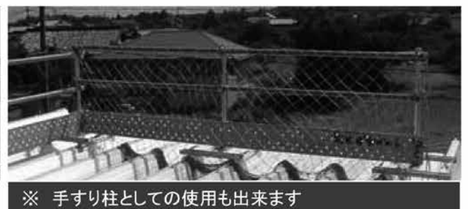
③ ハゼ金具をボルト・ナットで固定
