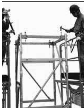
⑥ エンドサポートを固定しヘッドスピンドルを差し込みます。
