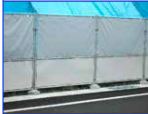
フェンスバリケード
