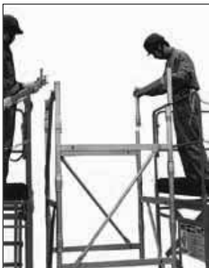
⑤ エンドフレーム、エンドサポートを差し込みます。
