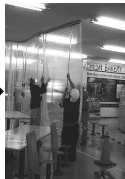
③ 棒をジャッキアップ
