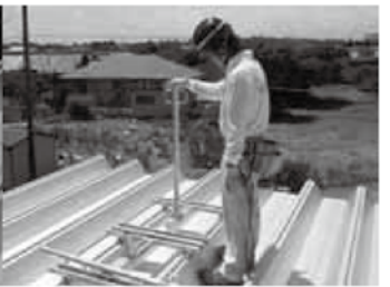
④ 親綱支柱のセット
