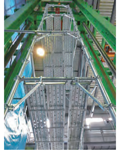
支柱強化の荷重試験
