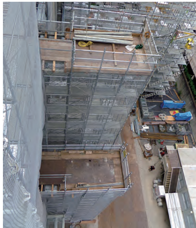
物流倉庫工事でスラブにレベルを合せて設置したフォークリフト用の荷受構台。敷鉄板敷設。 大引受ジャッキを使用しても外周に手すりを簡単に設置することが可能。
