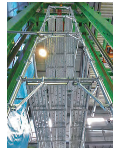
支柱強化の荷重試験
